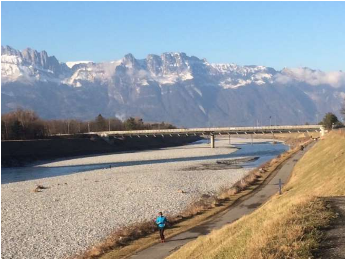
Abbildung 7 Rhein mit Kiesablagerungen bei Vaduz
