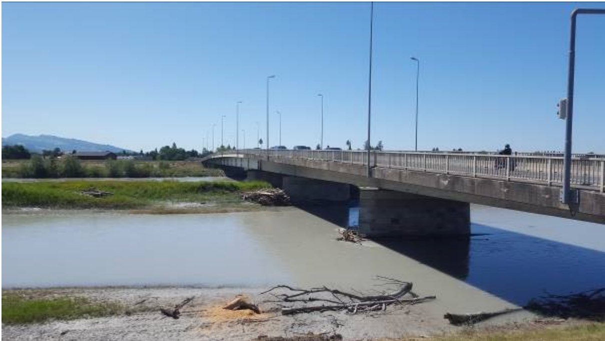
Abbildung 4: Ablagerungen und Schwemmholz
