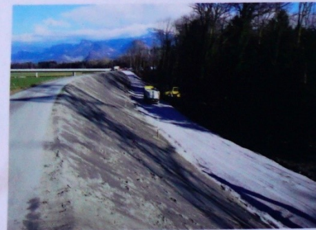
Bild 6: Die Interventionspiste ermöglicht die Kontrolle und Zufahrt entlang der Aussendämme insbesondere bei Hochwasser. Zusätzlich wird die Dammschüttung durch die Auflastschüttung erhöht.
