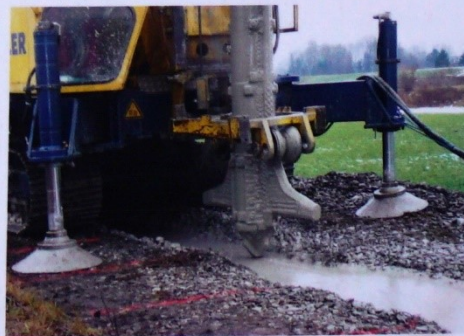
Bild 5: Über den Düsenkopf wird die Suspension in den Hochwasserdamm eingebracht.
